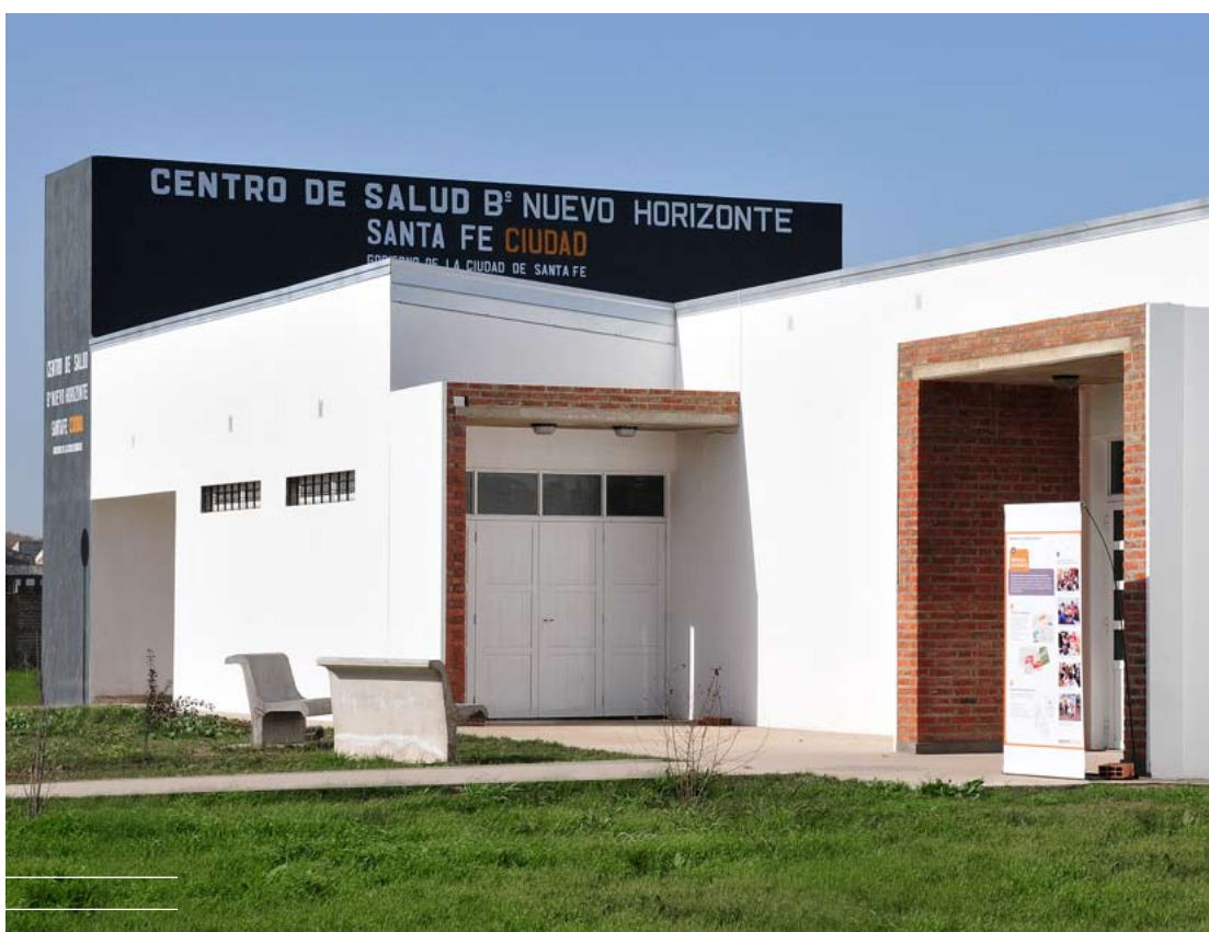
Se construyó el primer centro de salud municipal, obra elegida en el marco del Presupuesto Participativo.
